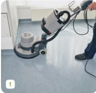
Abtrag des alten Pflegefilmes linear im Kreuzgang
