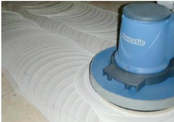
Einarbeitung des Kristallisationsmittels.
