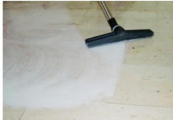
Absaugen der Kristallisationsschlämme
